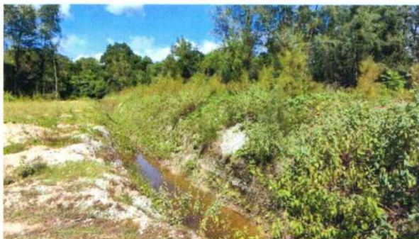
รูปที่ 9 คันทำนบกั้น ขุดคูน้ำและต้นสนปลูกไว้รอบเขตโรงโม่
