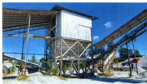
รูปที่ 14 ติดตั้ง Metal Sheet ปิดคลุมอาคารโรงโม่หิน
